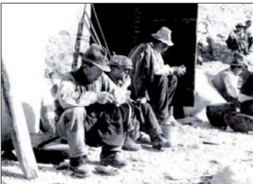
Foto 6.2.1. Il cavatore è un lavoro molto pesante (foto: Bessi).
